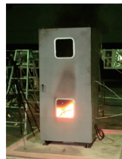
図4 18kWh相当の蓄電池設備の延焼状況
